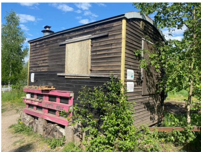
Redskapsbrakka før rehabilitering
